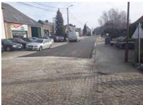
Les travaux de la réfection de la chaussée de Gramptinne à Gesves, pilotée par la Région wallonne, sont presque terminés. Le chantier se termine par le remplacement du revêtement du dernier tronçon allant de la rue de Sierpont au cimetière. La commune et l'INASEP ont entrepris précédemment dans cette zone la pose de canalisations et de collecteurs afin de permettre l'égouttage et l'épuration des eaux usées des habitations du quartier.
