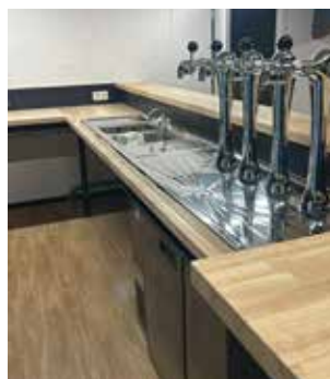
Equipement de la buvette du hall des sports
