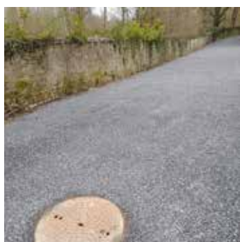
Refection du chemin le long du mur du château
