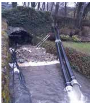
Consolidation du pont rue des Carrières
