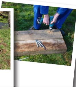
Étape 1 : préparer le sol, mettre à niveau le socle, forer les trous pour les fers à béton et les tire-fonds
