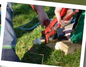
Étape 4 : couper la longueur de socarex nécessaire pour atteindre la zone d'alimentation à une distance maximale du bac de 200m, pour limiter les pertes de charge. Fixer une extrémité au té et la crépine à l'autre extrémité, à l'aide du raccord HUOT préalablement étanchéifié avec du téflon
