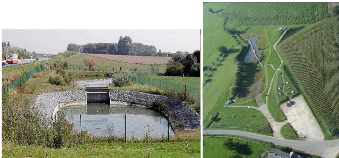
Figure 61 : Bassin d'orage classique (gauche) et ZIT multifonctionnelle (droite) (source : SPW-DGO3)
