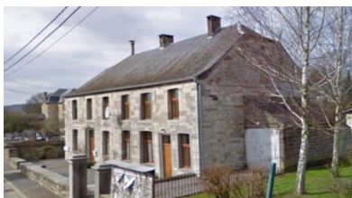
Rue de l'Eglise à 5340 Faulx-Les Tombes
