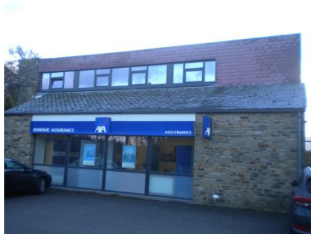
Rue Bouchet à Gesves
