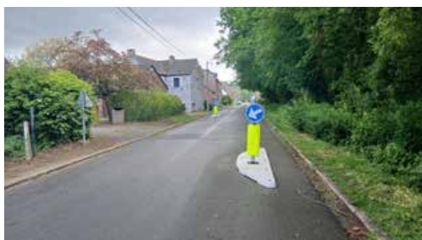
Pose de chicanes à Faulx-Les Tombes
