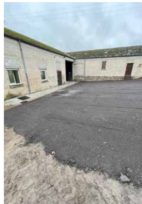
Nouvel égouttage et réfection de la cour de l'ancien garage communal
