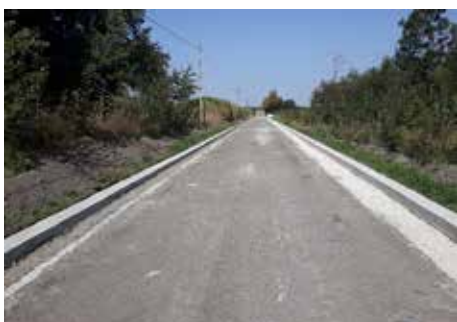
Début des travaux de réfection de la chaussée de Gramptinne dans le cadre du Plan Infrastructures de la Région wallonne, ici à Gramptinne.
