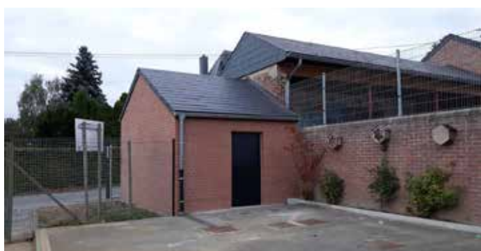
Nouvel abri à vélos à l'école de l'Envol
