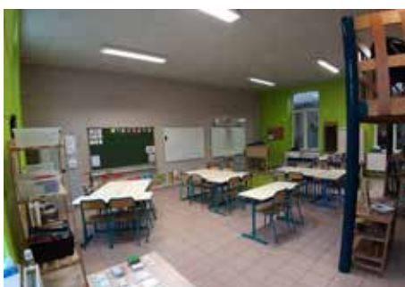
Travaux de peinture à l'école de la Croisette à Sorée
