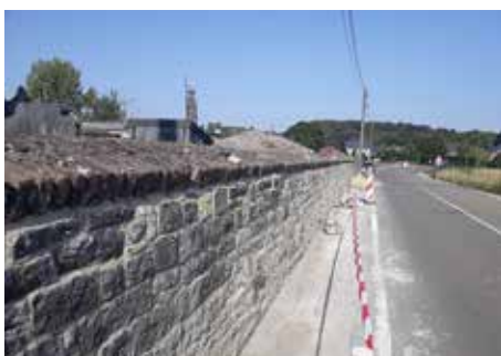
Rénovation du mur du cimetière de Gesves
