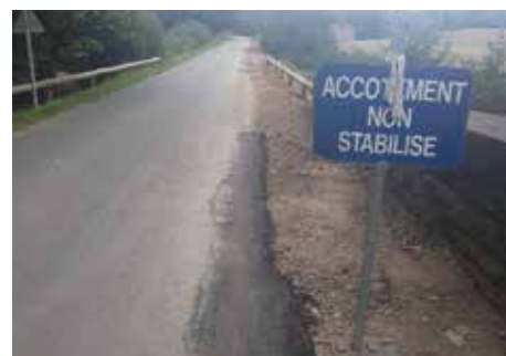
Tranchée route d'Andenne entre Faulx-Les Tombes et Strud afin d'amener l'Internet à Strud
