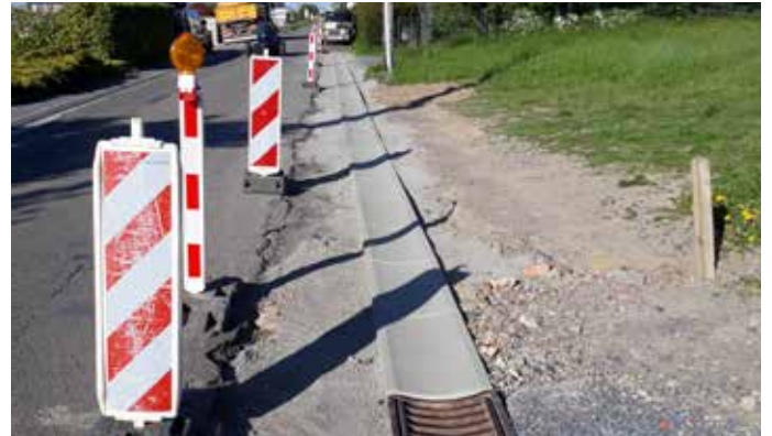
Rue du Pourrain à Gesves – stabilisation
