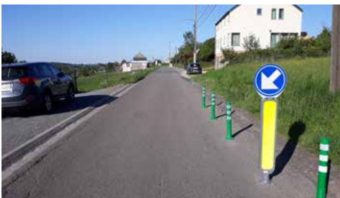
Rue du Pourrain à Gesves - sécurisation
