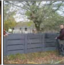
Et encore, Simon et Augustin qui installent les composteurs
