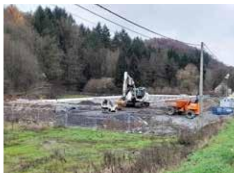
Travaux à la station épuration à Gesves
