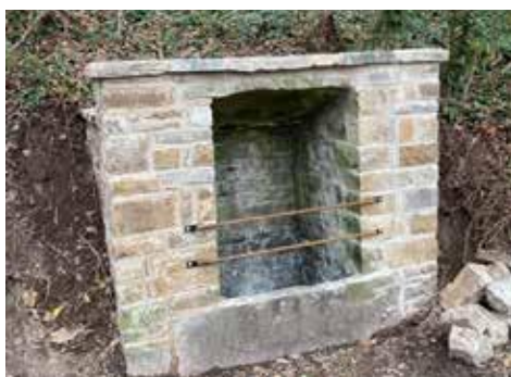
Rénovation d'un puits à la route 66 à Gesves
